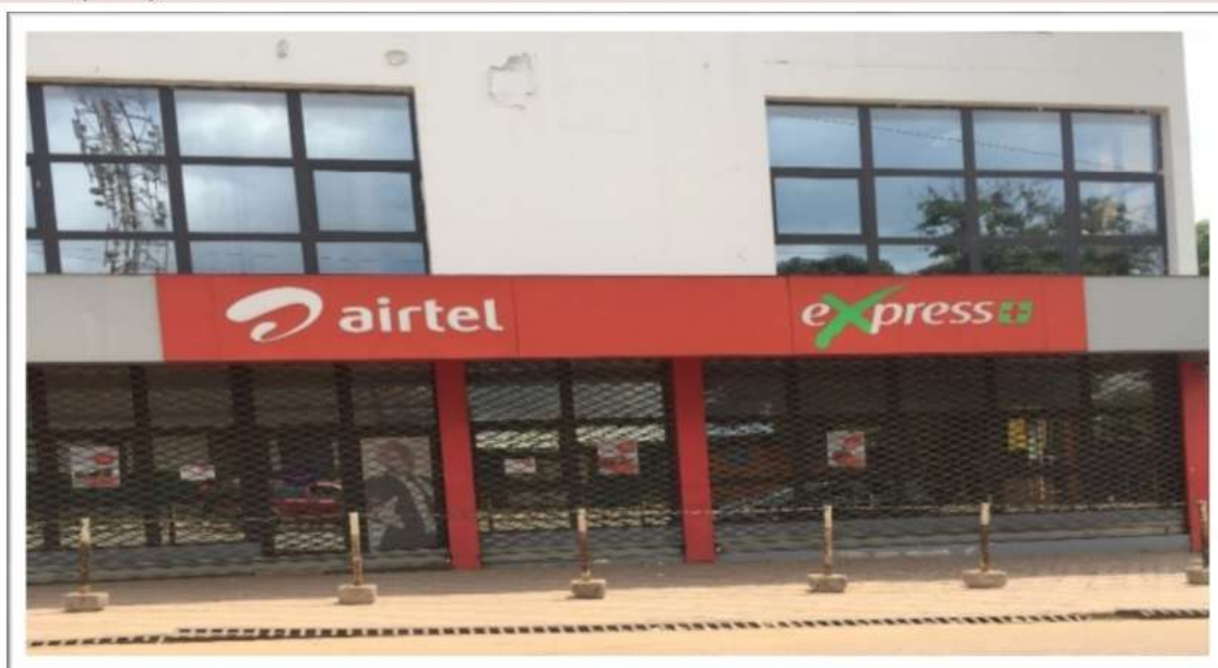
Figure 8 : Bâtiment d'Airtel (Matadi)
