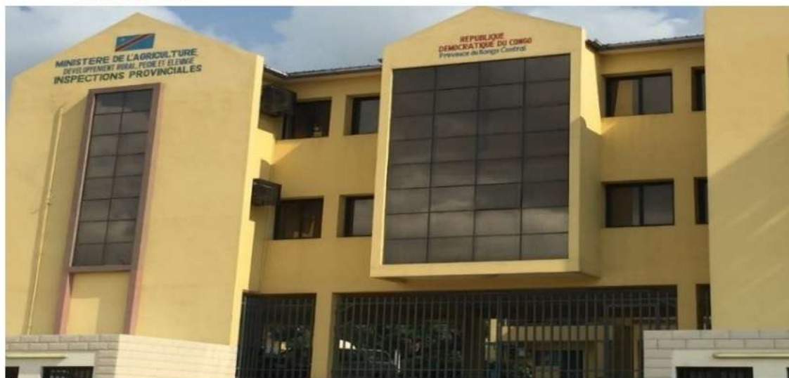
Figure 10 : Bâtiment Administratif (Matadi)
